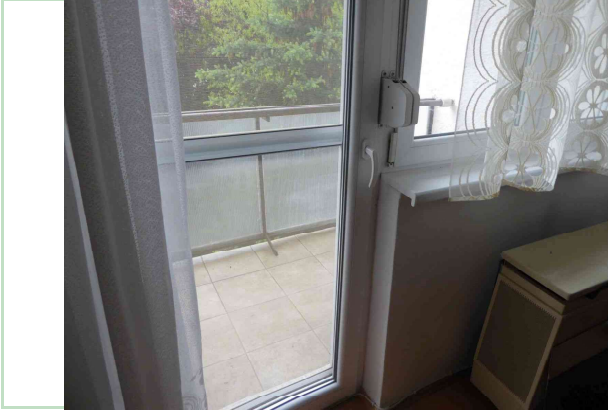
Megjegyzés: Nyílászáró - erkélyajtó
